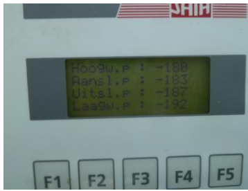
Afbeelding 29: De instellingen van het elektrische gemaal in de Klaas Hennepoelpolder
